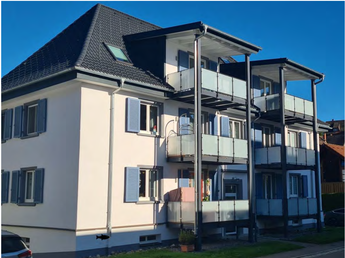
Biberwiese 3 nach dem Umbau
