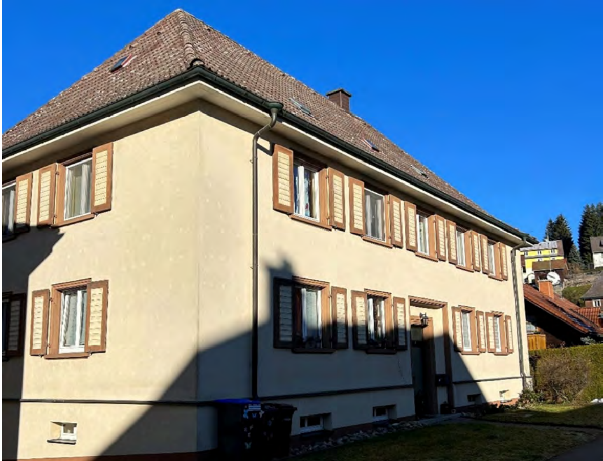
Biberwiese 3 vor dem Umbau
